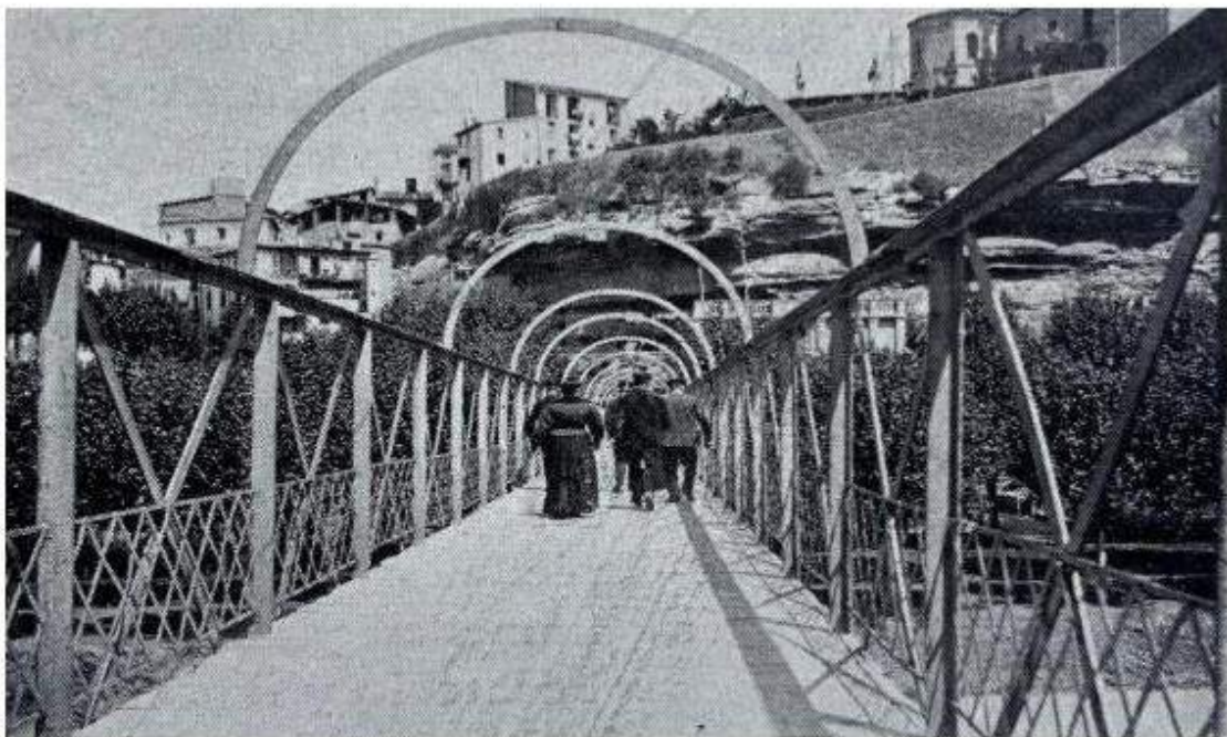
Figura 2.- Fotografia presa l'any 1903 per Adolf Mas de la palanca de ferro que comunicava l'estació del nord amb el carrer de les Piques per anar cap a la Plana i la resta de la ciutat. La fotografia es va publicar a la revista "La fotografia pràctica". (AJVMP).
