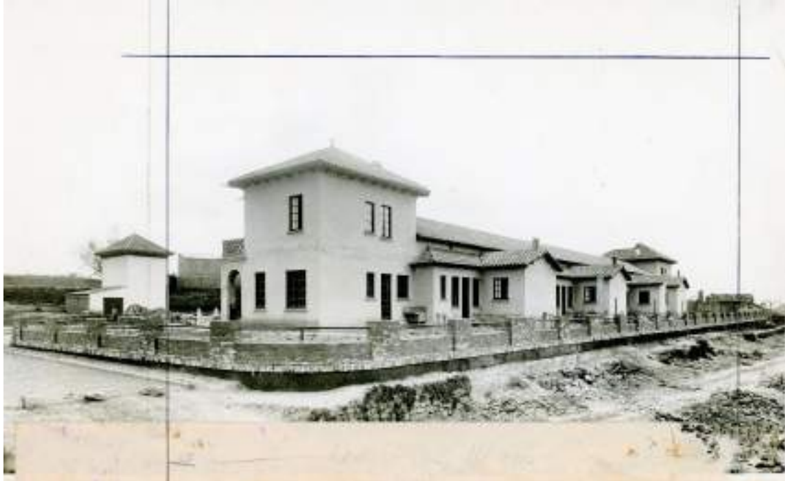
Figura 4.- Vista durant la construcció de les Cases Barates que l'obra social de la Caixa d'Estalvis de Manresa va construir entre els anys 1931 i 1932 a la cantonada de la Carretera del Pont de Vilomara amb el carrer Viladordis. Es pot apreciar que la fotografia es va utilitzar per fer l'enquadrament exacte de cara a inserir-la en algun document de l'època. (AJVMP).
