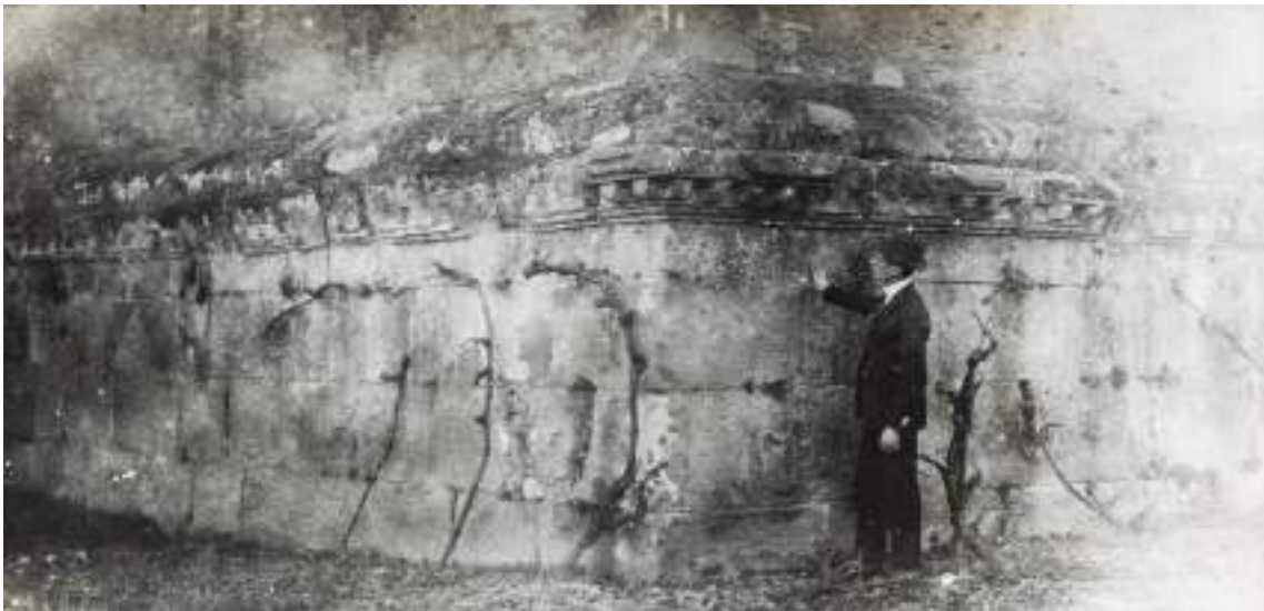
Figura 5.- Fotografia presa per Isidre Vives l'any 1931 del basament de la Torre del Breny tal com estava aleshores. La imatge encara conservava aquesta part del monument fúnebre tal com havia estat des de la seva construcció. (AJCMP).
