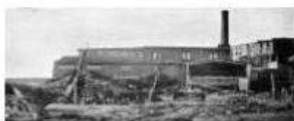
Figura 3.- Josep Daura va fer un ampli reportatge dels estralls causats per riuada de la matinada del dia 4 d'octubre de 1907 que va produir grans danys a totes les fàbriques d'elavora del riu. Aquí es va deixar la imatge de com va quedar la fàbrica tèxtil de Cal Cots, situada al costat del riu Cardener, entre el pont de Sant Francesc i la palanca de ferro de l'estació del nord, aleshores explotada per en Lluís Viñas i Guix. (AJVMP).
