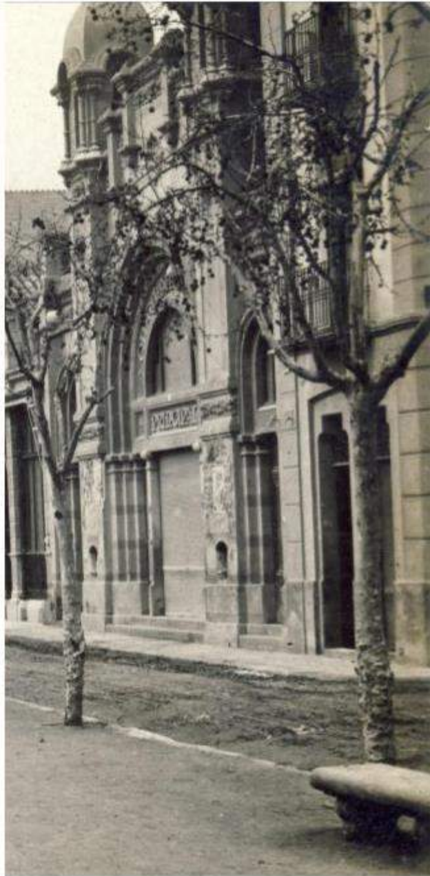
Figura 2.- Detall de la vista del "Cinematógrafo Principal" situat al número 12 del Passeig Pere III l'any 1910 on es poden apreciar els cartells anunciadors de pel·lícules a banda i banda de la porta principal. Edifici construït per la raó social "Serra Soldevila&Abadal" l'any 1903, obra de l'arquitecte Ignasi Oms i Ponsa. El cinema va estar en actiu fins l'any 1913. (AJVMP).
