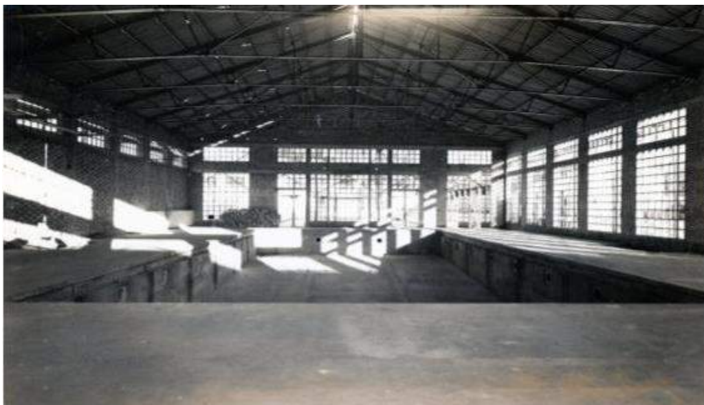
Figura 4.- Fotografia de Marià Lladó poc abans de la inauguració, que es va celebrar el dia 18 de juny de 1955, de la piscina coberta de 25 metres de llarg. Al mig el vas de la piscina encara per enrajolar i la coberta per tancar interiorment. (AJVMP).
