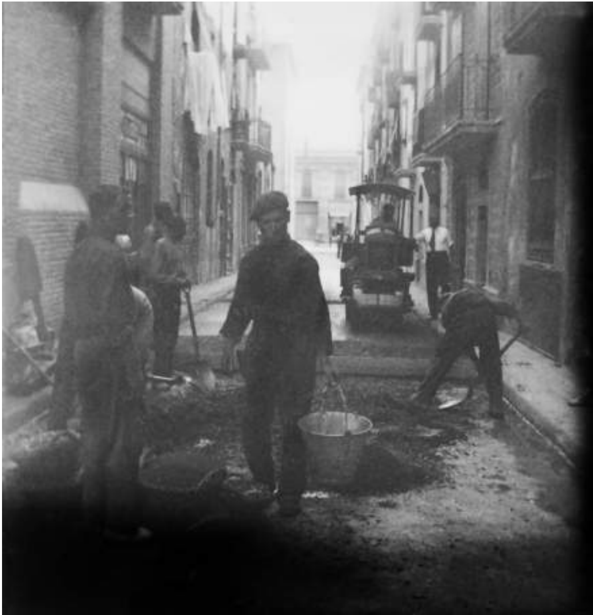
Figura 4.- Pavimentació del carrer Flors de Maig, aleshores anomenat Arcs, l'any 1929 després d'haver-hi construït el clavegueram. Fotografia presa per Baltasar Portabella. (AJVMP).
