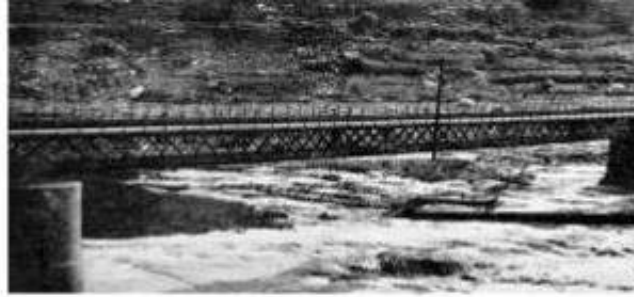
Figura 4.- Dintre de la sèrie de fotografies que ens ha deixat Josep Daura dels estralls causat per la riuada del 12 d'octubre de 1907 hi ha aquesta imatge del pont dels ferrocarril dels Comtals. Es pot apreciar com l'aigua es va emportar el pilar del mig que ha desaparegut. Aquestes fotografies es van publicar a la revista barcelonina "ORBI" de curiositats científiques, art i història, invents moderns i actualitat número 56 del 26 d'octubre de 1907. (AJVMP).
