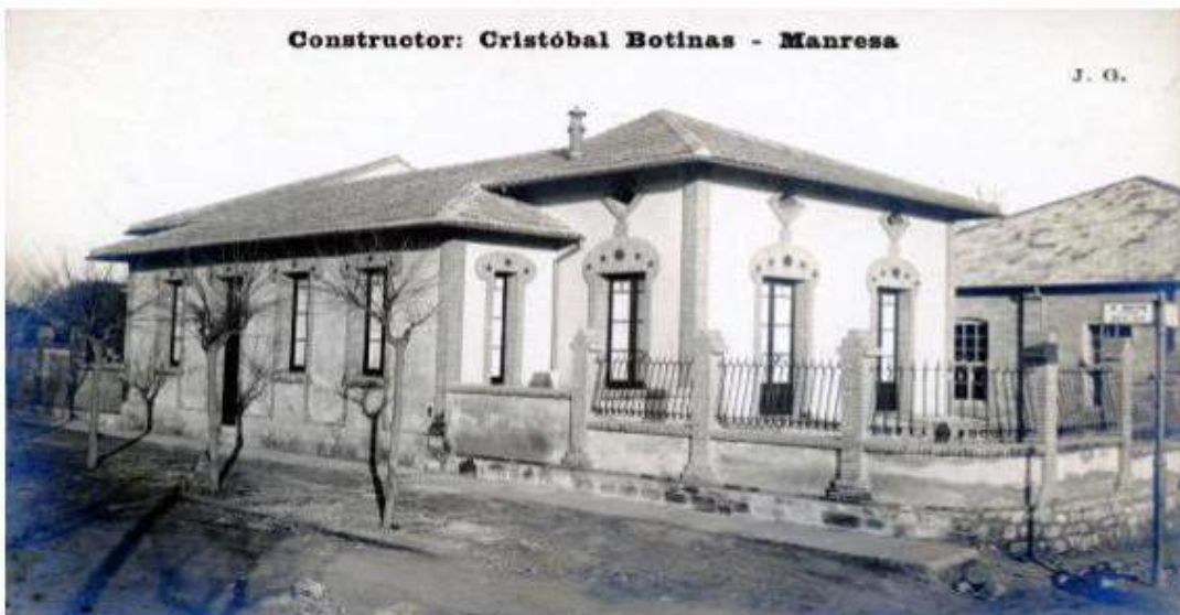
Figura 15.- Nou edifici construït pel mestre d'obres i constructor Cristòfol Botinas de l'escola "Bonavista" inaugura l'any 1913 situat a la cantonada de la Carretera del Pont de Vilomara i del carrer Mossèn Cinto Verdaguer, que al finalitzar la guerra civil se li va canviar el nom pel del jesuïta manresà "Pare Algué". La fotografia presa per Josep Guixà (les seves inicials de J.G.) va ser editada per Cristòfol Botinas dintre de la col·lecció de 7 postals de les obres que havia fet a la ciutat. (AJVMP).
