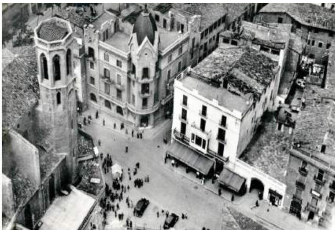
Figura 2.- Vista aèria captada pel fotògraf Josep Gaspar en el vol que va fer el mes de maig de 1936. La vista ens mostra la Plaça de Sant Domènec des de migjorn on s'aprecia l'Hotel de "Sant Domingo" l'edifici de la Caixa de Pensions. D'aquestes vistes en va fer una col·lecció de postals el mes de juliol de 1936. (AJVMP).
