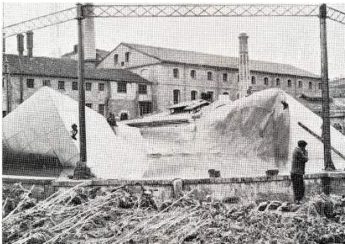
Figura 1.- Esta en quedà el gasòmetre per la implosió que va patir com a conseqüència de la riuada del dia 12 d'octubre de 1907. La fotografia va ser presa per aquest fotògraf el diumenge 20 d'octubre en que acompanyà al rei Alfons XIII en la visita que va fer a Manresa per veure els estralls causats. La fotografia es va publicar a la revista "La Ilustración Española y Americana" del dia 30 d'octubre de 1907. (AJVMP).
