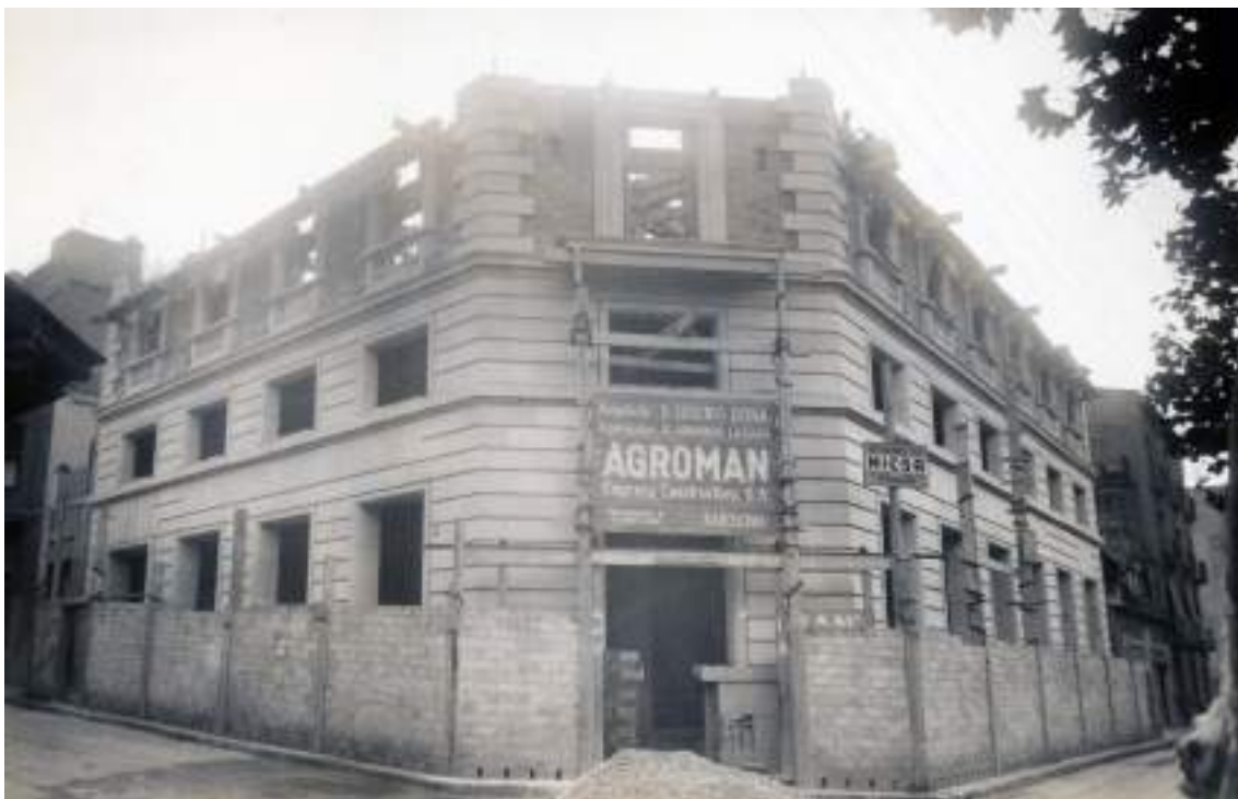
Figura 7.- Fotografia realitzada el dia 21 d'octubre de 1950 per l'estudi Villaplana, que regentava la seva vídua Encarnació Xarpell, de l'obra de construcció de l'edifici situat a la cantonada del Passeig Pere III amb el carrer Canonge Montanyà per ser la seu a Manresa del "Banco Español de Crédito". (AJVMP).
